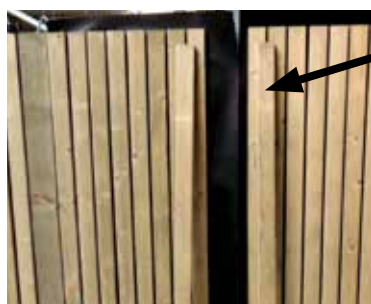
Visser le cadre de la paroi dans la poutre du dessus à l'aide de 2 vis 5x70mm
