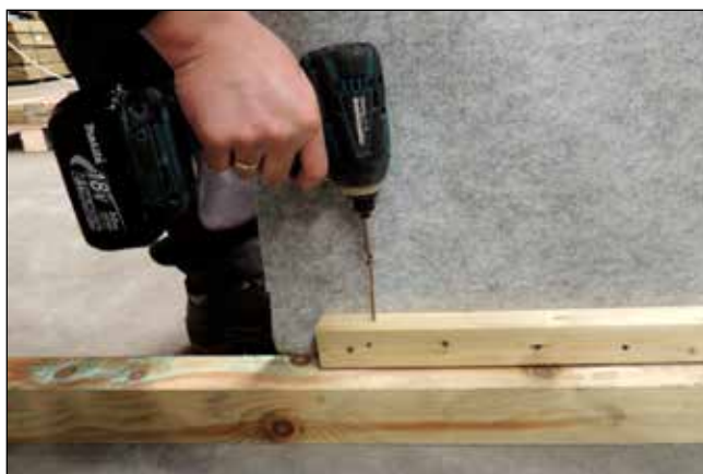
Visser le cadre de la paroi dans la poutre du dessous à l'aide de 2 vis 5x70mm
