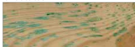
Les efflorescences de sel s'estompent avec le temps
